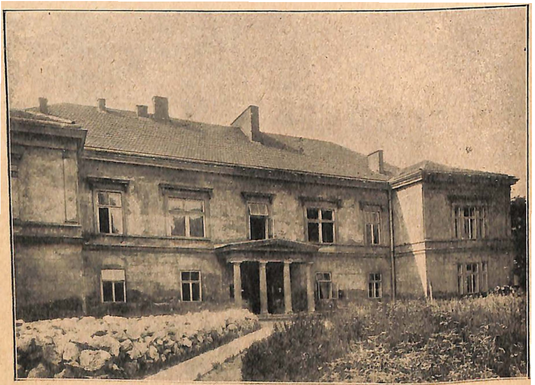
Siedziba loży Przesąd Zwyciężony na ws. Krakowa odszukana i ustalona przez autora. B. dom Likego; obecnie mieści się w nim laboratorium chemiczne Uniwersytetu Jagiellońskiego (Kopernika 7). Fot. A. Pawlikowski w Krakowie.
